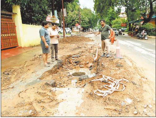
सिवरेज पाइप लाइन बिछाने मार्ग में खोदा गया गड्ढा ।
